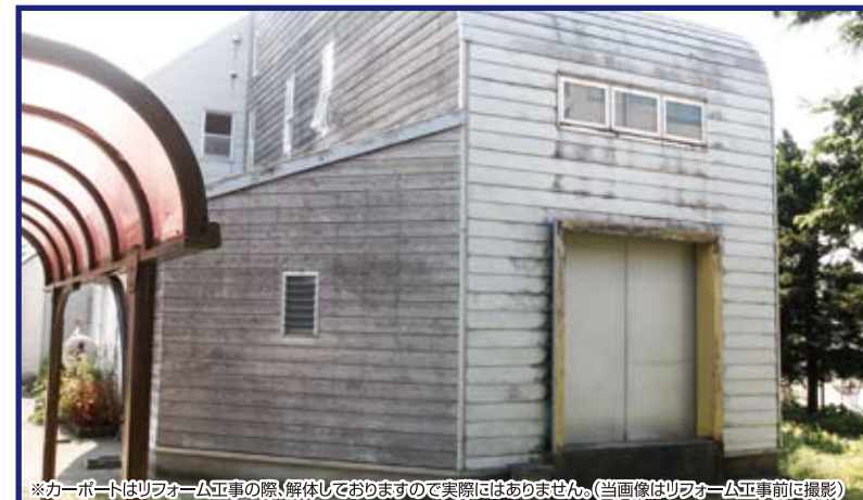
※カーポートはリフォーム工事の際に解体しておりますので実際にはありません。(当画像はリフォーム工事前に撮影)
